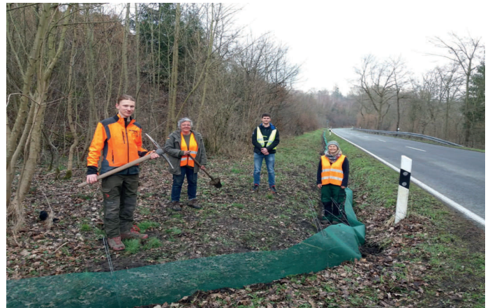
Aufbau des Amphibienschutzzauns.
